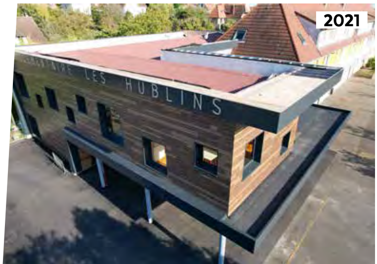
Extension de l'école des Hublins
