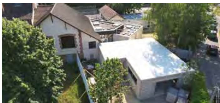
◀ Création d'une annexe à l'école de L'Hautil (en cours)
