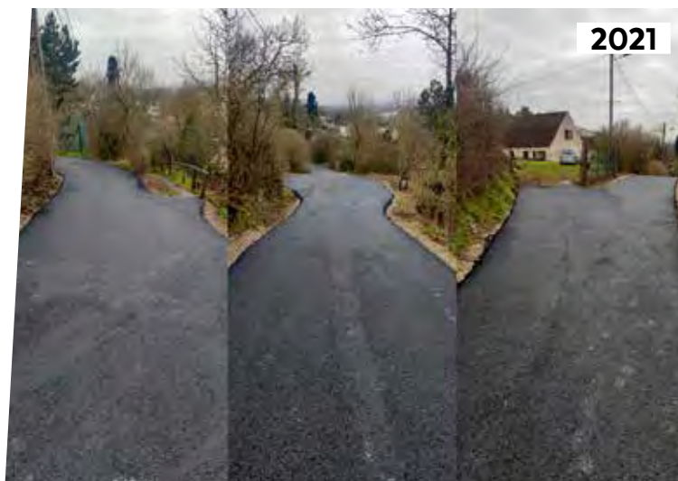
Rénovation de la chaussée côte Mathias
