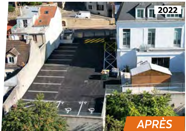
Rénovation du parking de la Maison de Santé
