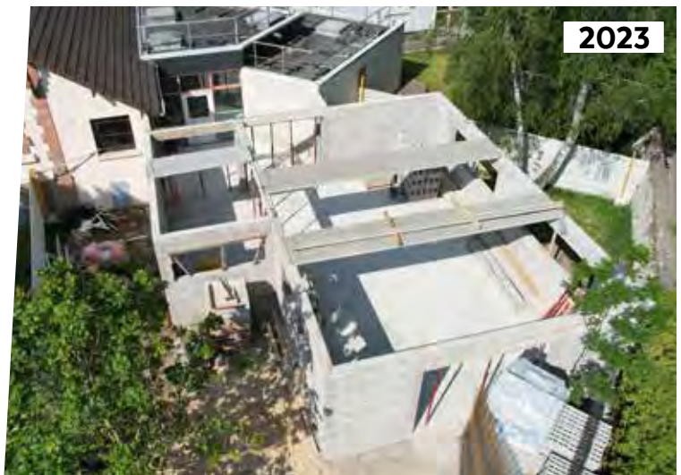
Extension de l'école de L'Hautil (en cours)
