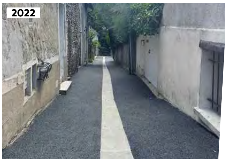
Rénovation de la chaussée impasse des Cerisaiés
