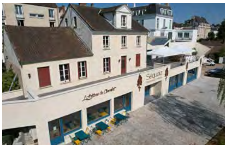
◀ Construction de deux commerces place Philippe Prévost
