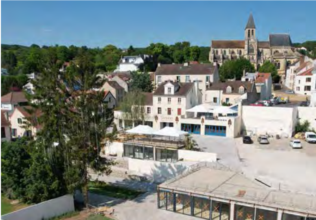
◀ Aménagement en cours de la place Philippe Prévost
