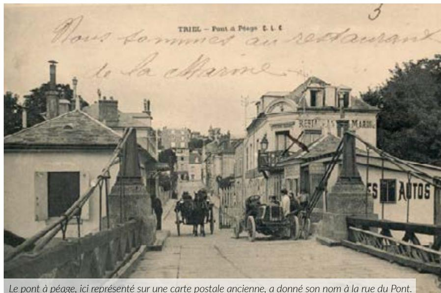
« fil de fer » avec un tablier de bois – est prévu d'une longueur de 163 mètres et d'une largeur de 5.40 mètres et son coût final de construction, tel qu'il apparaît dans les archives Seguin, est de 157.634 francs.
