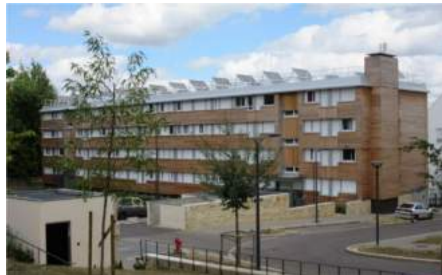
Photo 1 : Réhabilitation Cité du Parc à Ecquevilly Source : GPS&O
