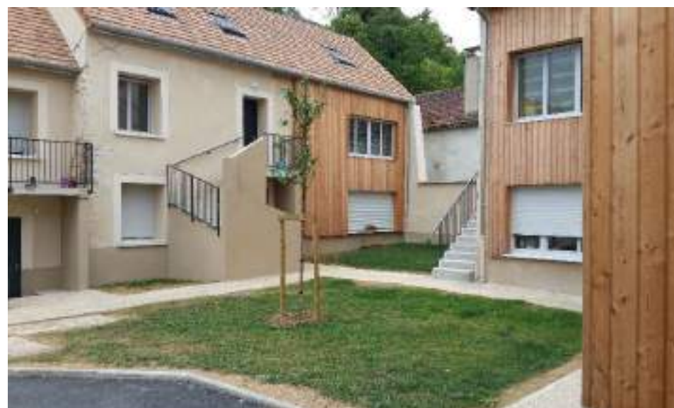
Photo 2 : Corps de ferme réhabilitée en logements à Guerville
